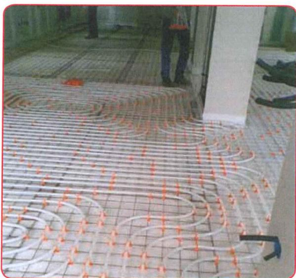
Figura 6: Sistema a pannelli radianti.
